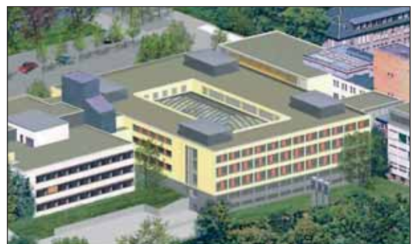
Neubau Sana-Klinikum Remscheid, wirtschaftliches Krankenhaus mit Energieverbrauchs- und Betriebskostengarantie für die gebäudetechnischen Anlagen über 15 Jahre
