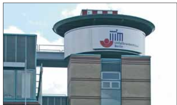
Das Unfallkrankenhaus Berlin hat im Jahr 2002 mit wesentlicher Unterstützung von MegaWATT ein Energiespar-Contracting erfolgreich eingeführt.
