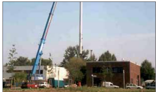
Aufstellen der Schornsteinanlage für eine BHKW-Anlage in Berlin, für die MegaWATT die Generalplanung ausführte.
