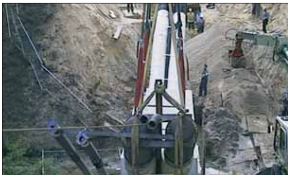
Zur Fernwärmeversorgung eines Berliner Industriegeländes wurde ein Wasserlauf mit einer Fernwärmetrasse DN 350 gequert. Der Düker wurde nach Vorgaben von MegaWATT komplett vorgefertigt angeliefert und in einem Stück eingebaut.
